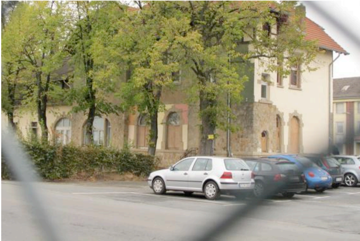
Das Hiltruper Bahnhofsgebäude ist bereits aus seinem Dornröschenschlaf erwacht. Schon bald soll sich auch im Bahnhofsumfeld einiges tun. (Foto: Dominique Snjka)
